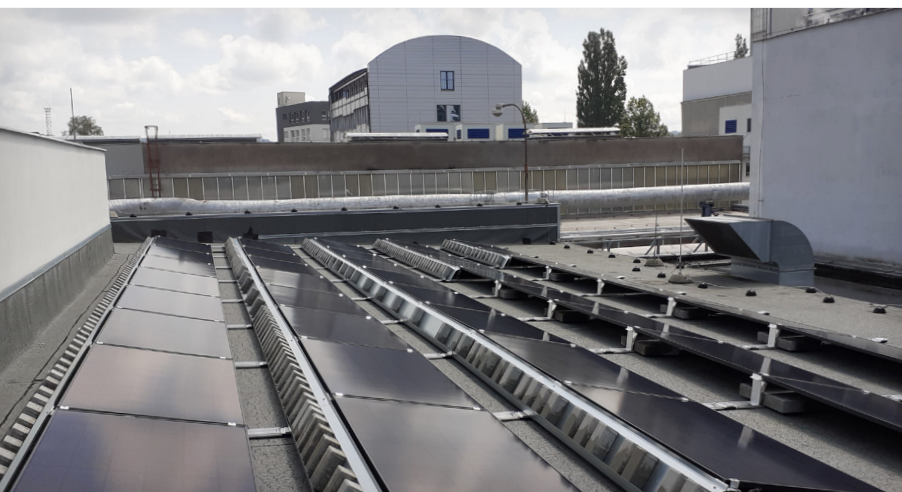
Fotovoltaická elektrárna se špičkovým výkonem 233 kilowatt. Celkem 593 solárních panelů je umístěno na střechách provozních budov Teplárny České Budějovice, které do výrobních provozů dodávají čistou energii. Předpokládaný roční objem vyrobené elektřiny se vzhledem k umístění odhaduje na zhruba 220 MWh.
