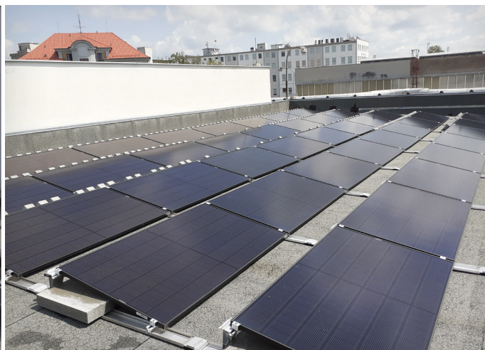
Fotovoltaická elektrárna se špičkovým výkonem 233 kilowatt. Celkem 593 solárních panelů je umístěno na střechách provozních budov Teplárny České Budějovice, které do výrobních provozů dodávají čistou energii. Předpokládaný roční objem vyrobené elektřiny se vzhledem k umístění odhaduje na zhruba 220 MWh.
