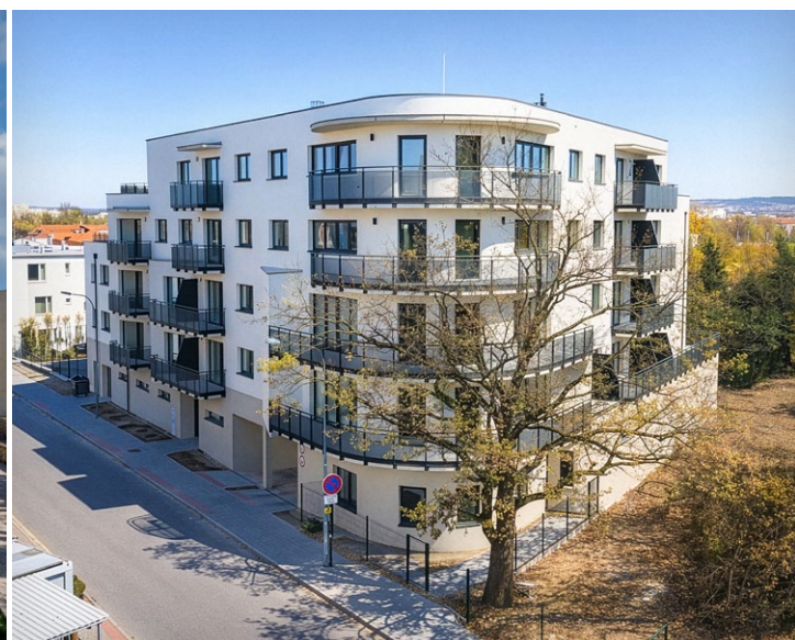
Bytový dům Zlatý Roh se napojil na horkovod teplárny v září 2025. Odebírá tepelnou energii pro vytápění a ohřev teplé vody.
