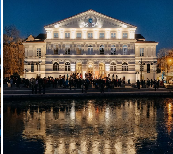
Zrekonstruovaná budova KD Slavie – Kulturní a kreativní centrum v srdci Českých Budějovic. Tuto ikonickou budovu vytápí městská teplárna od roku 1960.
